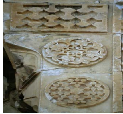
Resim 8. Aksaray Sultan Han, Taç kapı, ayrıntı
